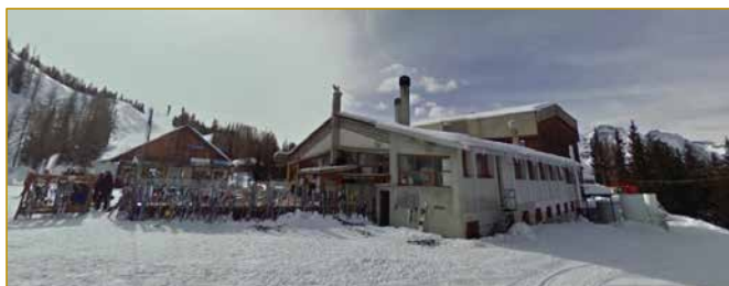
Figura 18: Strutture Alpe Palù
